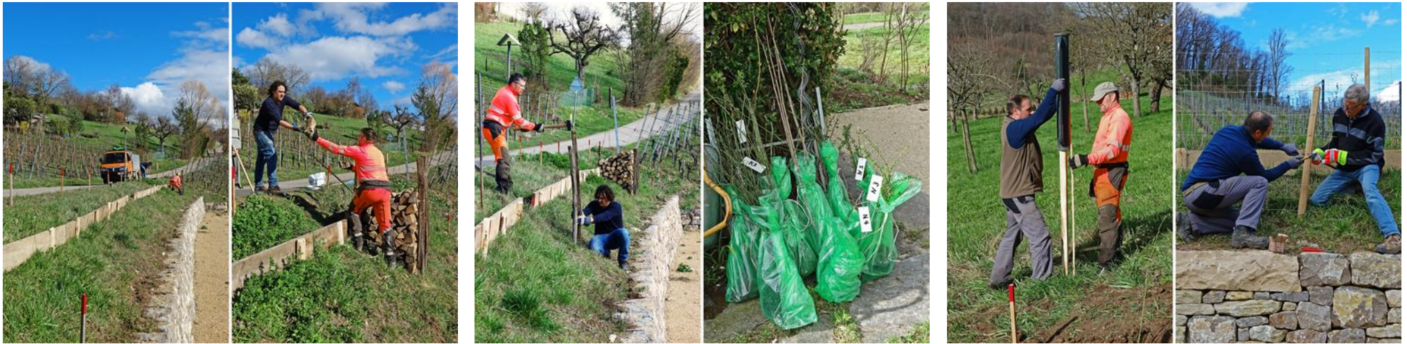
Vorbereitungen: Stellen von Stützbrettern an steilen Böschungen, Holzstapel integrieren und Pflanzen gruppieren.
