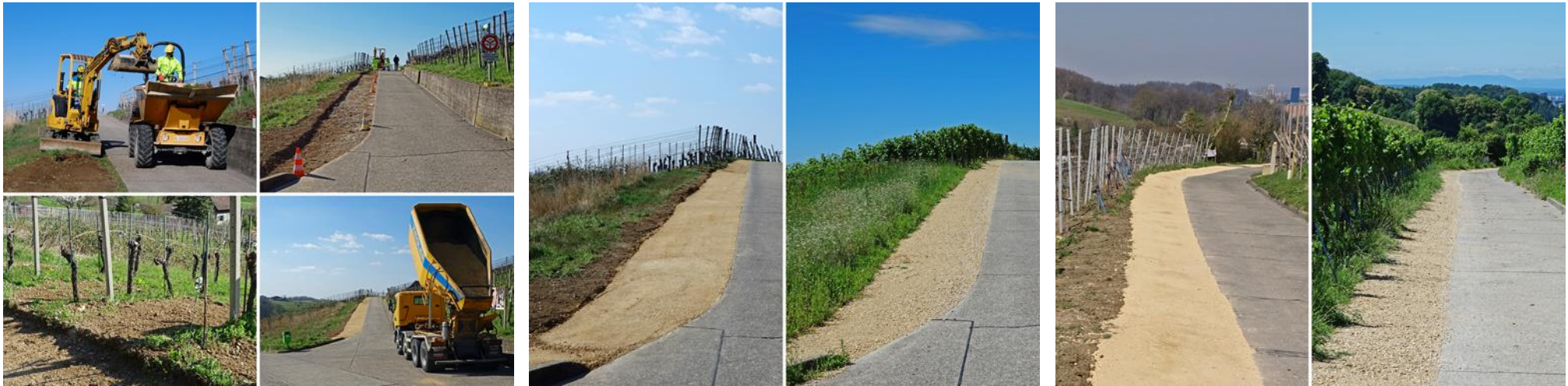
Schürfen, Material seitlich deponieren und Mergel einbringen
