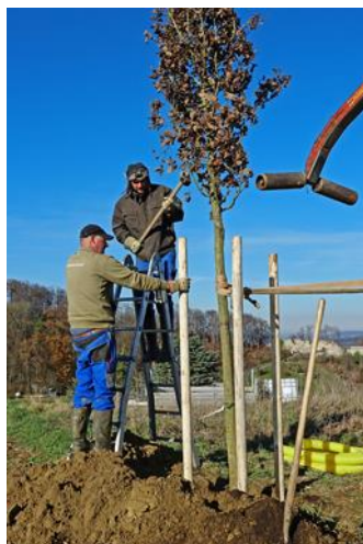
die Stützpfähle einrammen,
