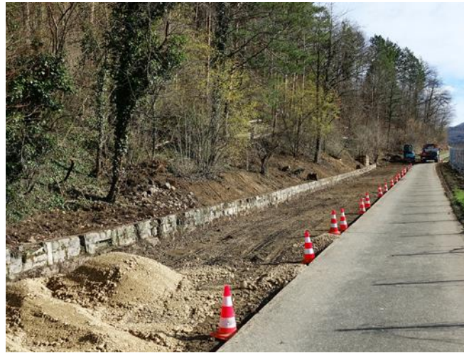
Der Waldrand ist aufgelichtet, der Oberboden abgetragen
