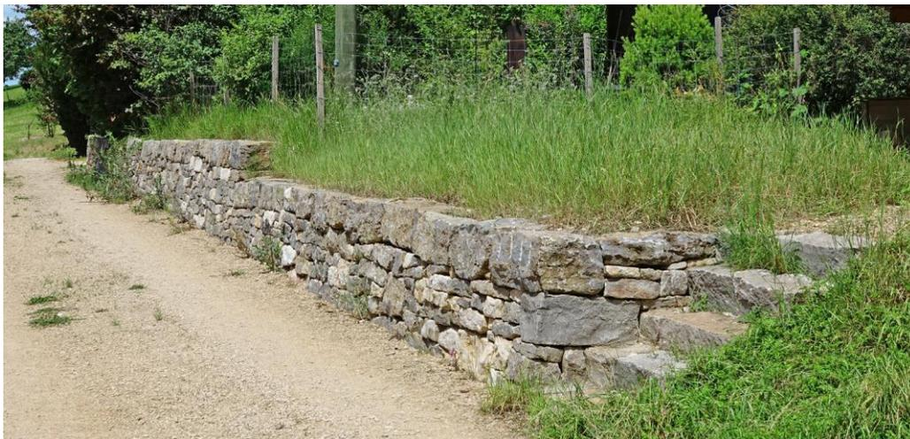
Im April 2017 erbaut, ersetzt diese TM teilweise eine Bahnschwellen-Wand und einen Bambusbestand. Parz. 2722-23, 30 m, 0.7–1.2 m hoch, 30 m<sup>2</sup>, Treppe, Heckenelement
