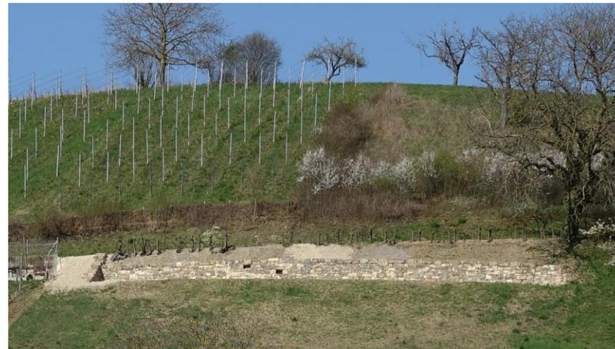
Im Okt./Nov. 2016 erbaut, ermöglicht sie dem Winzer oben zu wenden, neu, auf Parz. 2708, 35 m, 0.5–1.7 m hoch, 50 m<sup>2</sup>, 1 Rampe, WIH-Nihi
