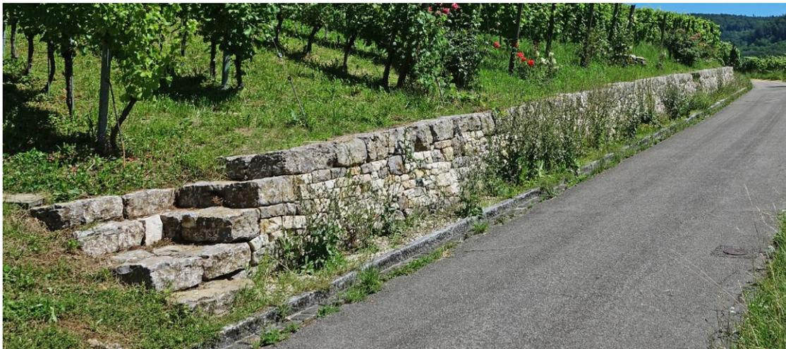
Im Okt./Nov. 2016 erbaut, ersetzt diese Trockenmauer eine brüchige Betonmauer aus dem Jahr 1934. Parz. 2423-24, 37 m, 1–1.2 m hoch, 41 m<sup>2</sup>, 2 integrierte Treppen, mageres Bankett
