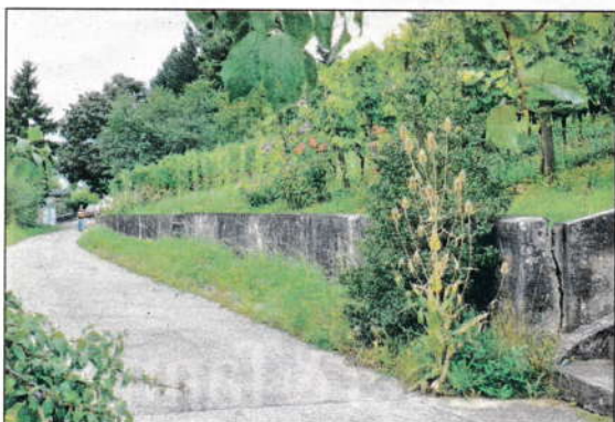
Die rissige und gerade Betonmauer (linkes Bild) aus dem Jahr 1934 wurde durch eine gschwungene Trockenmauer mit zwei Treppen ersetzt.
