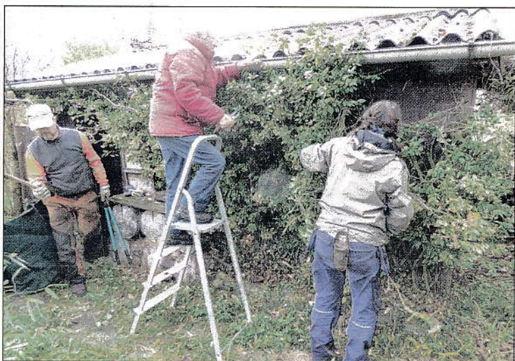
Damit der Zustand des Gartenhauses beurteilt werden kann, müssen die Pflanzen am Haus zurückgeschnitten werden.
