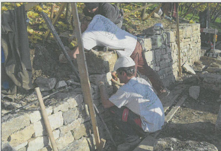
Über eine Tonne Naturstein wird auf einem sichtbaren Quadratmeter verbaut. Die Abschlusssteine müssen zum Passen gebracht werden.
