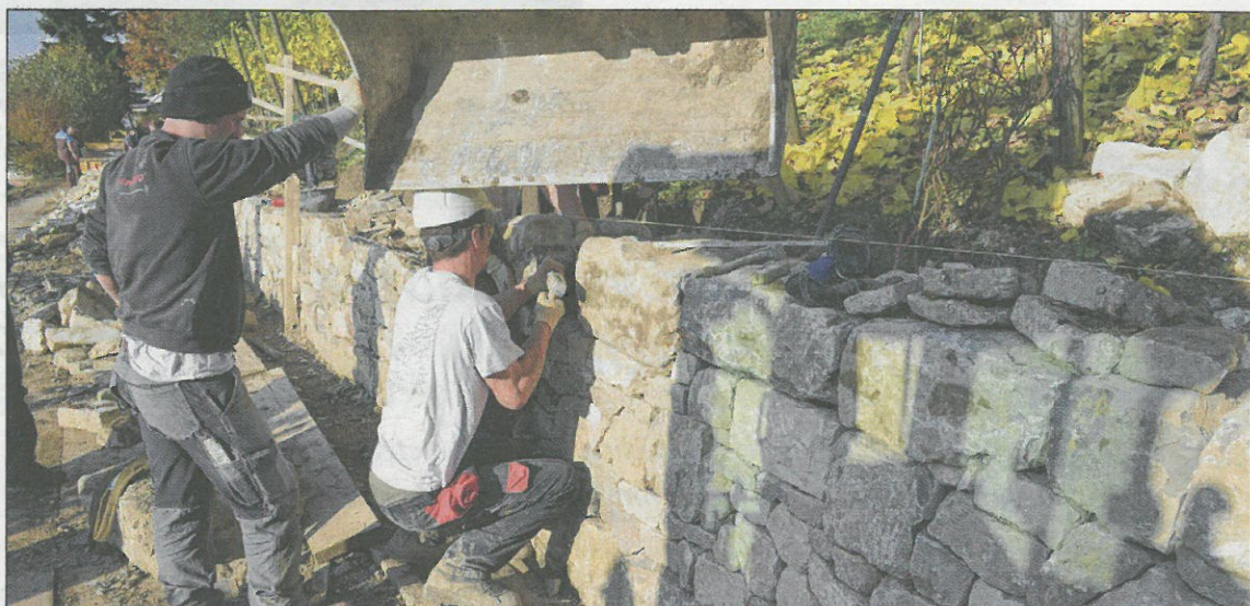
Eine neue Trockenmauer ersetzt an der Neusatzstrasse am Anfang des MuttENZer Rebbergs die bisherige Betonmauer. Die Erstellung erfordert viel handwerkliches Geschick und Kraft.
