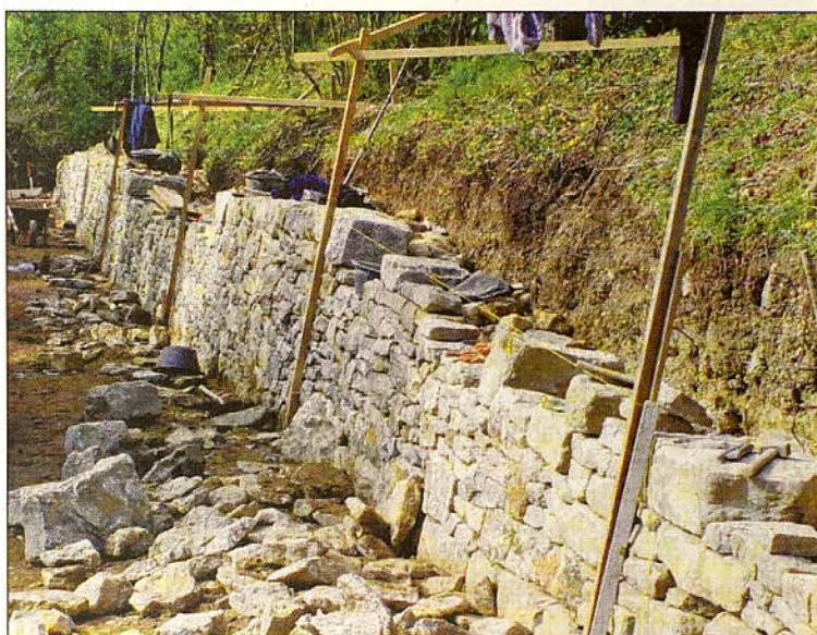
Eine Trockenmauer entsteht.
